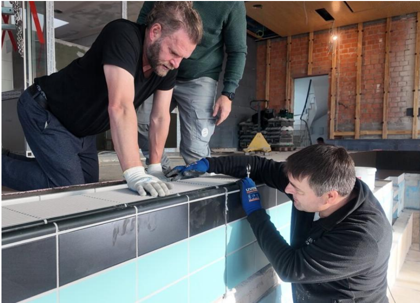
Andreas Kramer (r.), Leiter Architektenservice bei Agrob Buchtal, überprüft den präzisen Sitz des CarboCeram-Fertigbauteils ©agrob-buchtal.de
