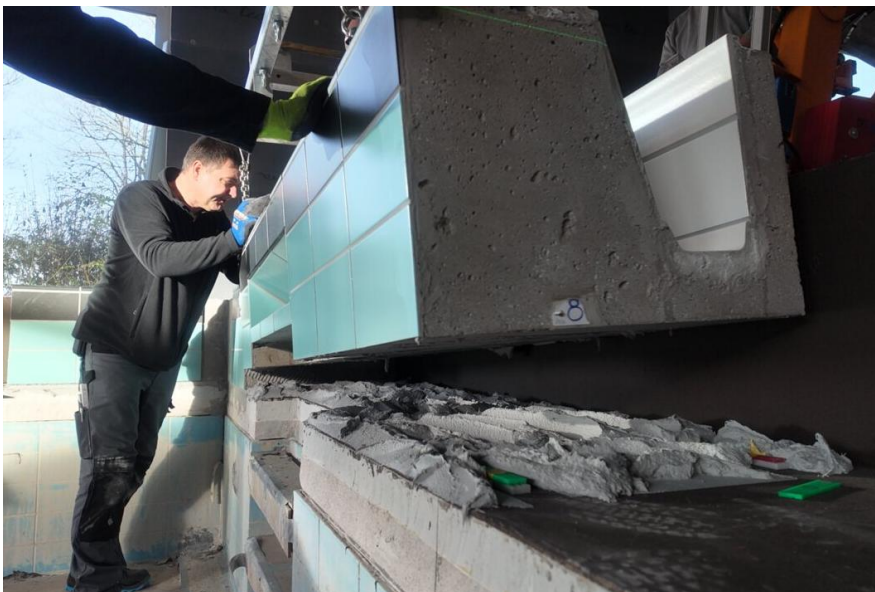
Fertigbauteil mit integrierter Sprossenleiter wird an seinen Platz gehoben. ©agrob-buchtal.de
